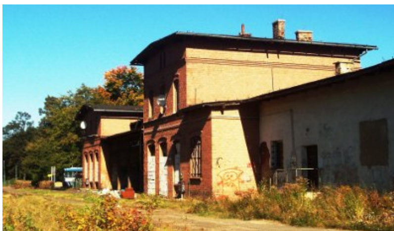
Pozostałości stacji kolejowej na trasie Jelenia Góra - Marciszów
